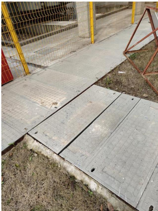
图 6-7 变电站南侧电缆沟
